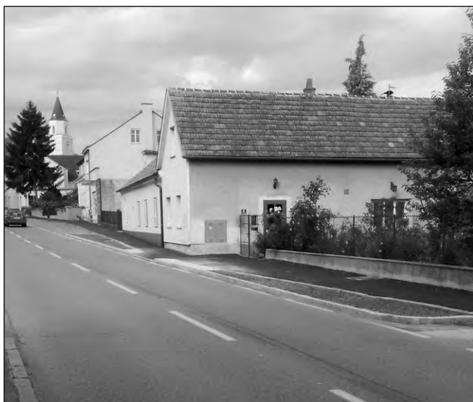
Die Nebenflächengestaltung im Bereich Volksschule und Postamt wurde bereits fertiggestellt.
