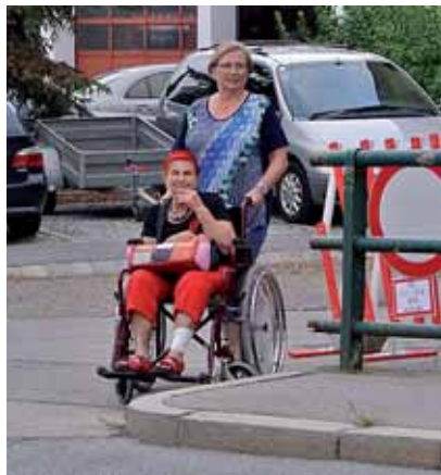
Ohne fremde Hilfe geht da nichts, fehlende Abschrägung beim Gehsteig
