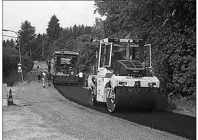
gezwungen, die Straßenbeleuchtung zu erneuern. Vor den Asphaltierungsarbeiten wurde auch noch der gesamte Unterbau für die Fahrbahn ausgewechselt, um einen längerfristigen Bestand zu gewährleisten.
