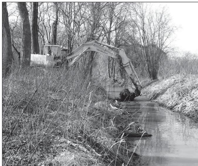
Seit einigen Tagen wird intensiv an der Ausbaggerung des Wassergrabens im Unterlauf des Hagenbaches gearbeitet. Diese Arbeiten sollen noch effizienter gewährleistet, dass der Abfluss in den Altarm verbessert wird. Nach Verhandlungen mit der NÖ Landesregierung und den Grundeigentümern (kein Grundbesitz der Gemeinde vorhanden) konnte mit den Arbeiten begonnen werden. Nach den Osterfeiertagen sollen die Arbeiten abgeschlossen sein. Auch das vom Gemeinderat
