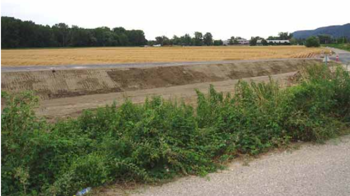
Abb. 2: Blick auf die Flächen Richtung Osten, im Hintergrund das bestehende Betriebsgebiet
